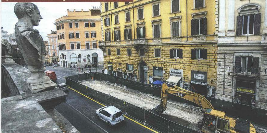
Ruipa in azione I lavori ieri mattina in via Nazionale, dove verranno sostituiti con asfalto i sampietrini causa di mille buche (foto di Claudio Guaitoli)
